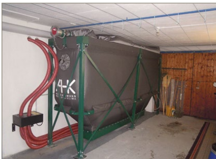
Abb. 10b: Trog silo mit mehreren Saugentnahmepunkten
