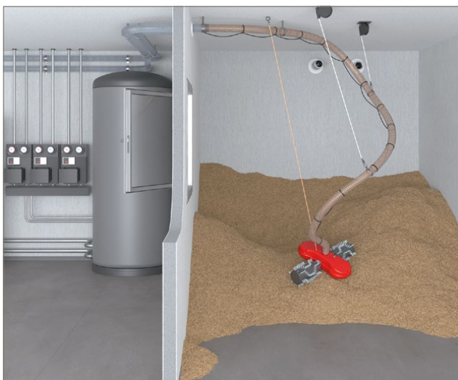
Abb. 22: Flachbodenlager mit Saugentnahme von oben
